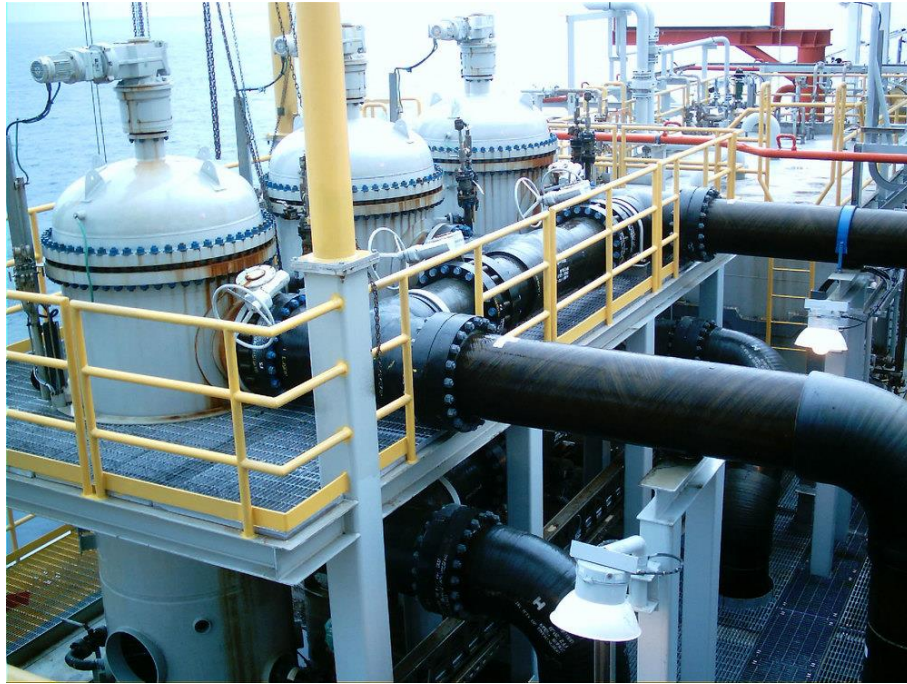
Figura 7: Tubulação de bomba de elevação de água do mar em plataforma de petróleo [13]
